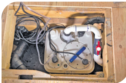
La Sanicubic® 1 installée dans un petit espace sous le plancher de bois de la maison flottante. Adolfo Rodas, PDG et propriétaire de AR Plumbing , et son équipe utilisèrent deux des quatre entrées disponibles.
