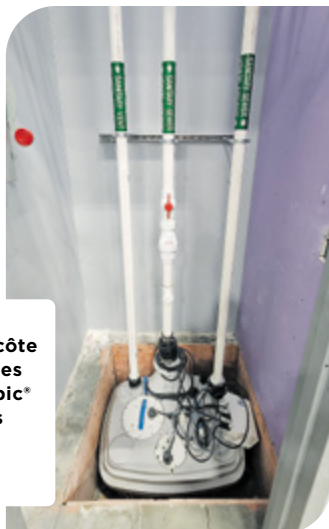
La Sanicubic® 2 VX placée dans un placard créé spécialement pour la pompe de l'autre côté de la salle de bain.
